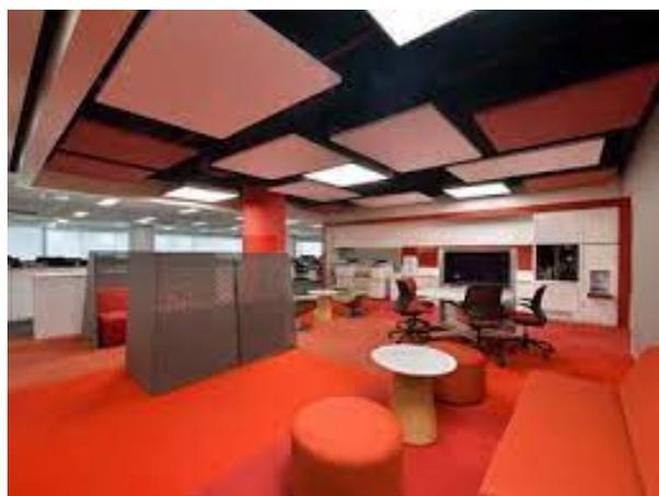
Esempi di applicazione delle isole fonoassorbenti pendinate a soffitto.
